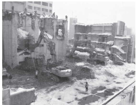
2月7日 北海道がんセンター新築工事風景(救急外来)
